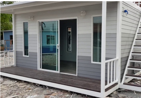
บ้านประกอบเสร็จ
