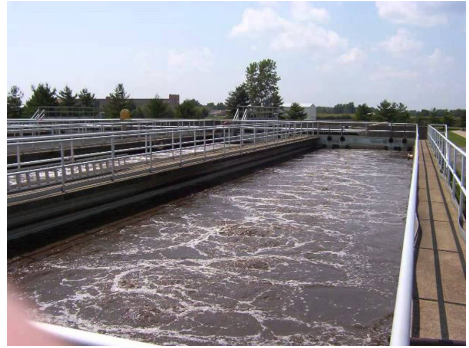
บ่อบำบัดน้ำเสีย
